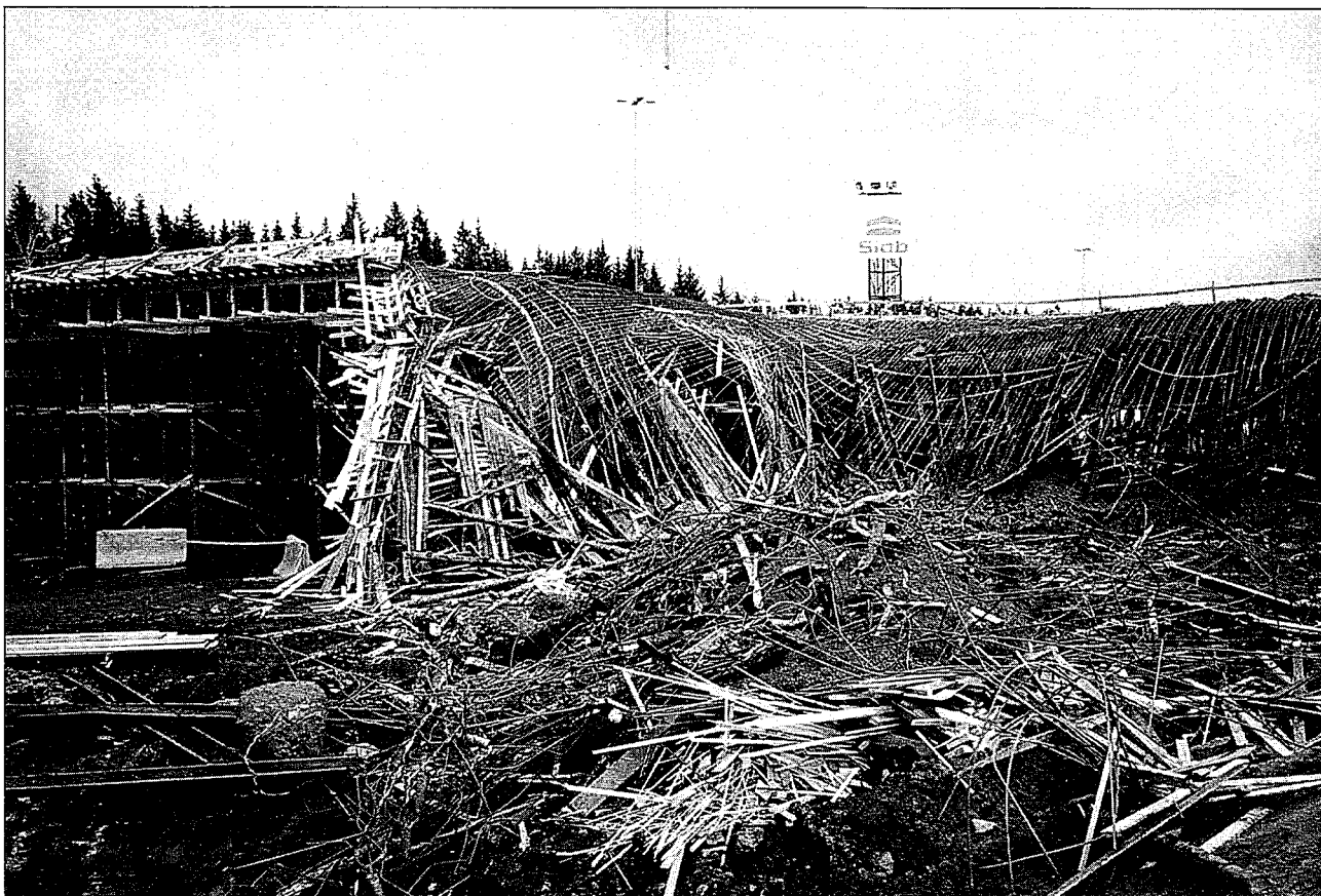
Formkonstruktion som kollapsat i samband med gjutning. Bro över riksväg 40 nära Borås.
